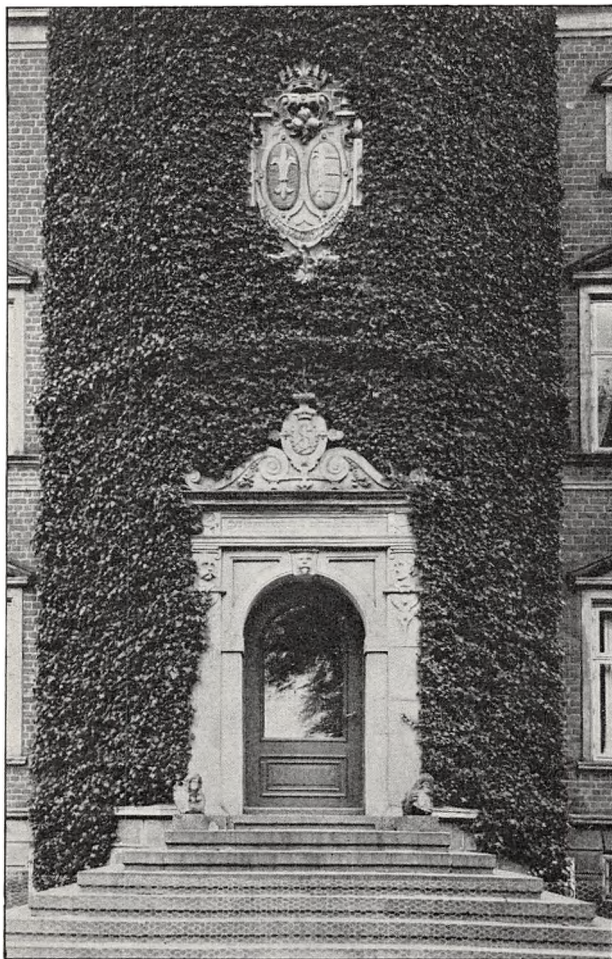
Fig. 74. Ravnholt. Opgangen i Taarnet fra Haven 1919.
