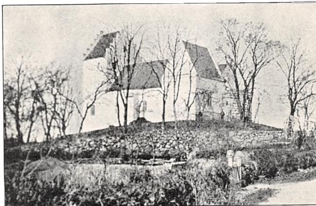
Fig. 76. Herrested Kirke før Restaureringen. Efter ældre Fotografi.
