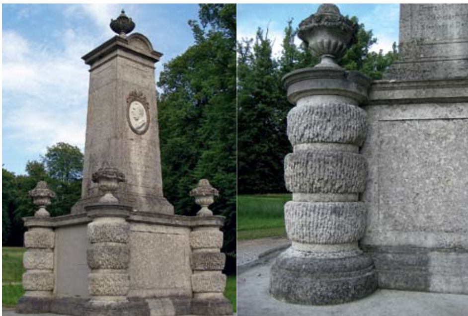
Mindestøtte for F. G. J. Moltke, 1825, Bregentved Slotspark. Her ses overfladen af sandstenen behandlet ”grotteret”, dvs. den imiterer drypstensformationer.
