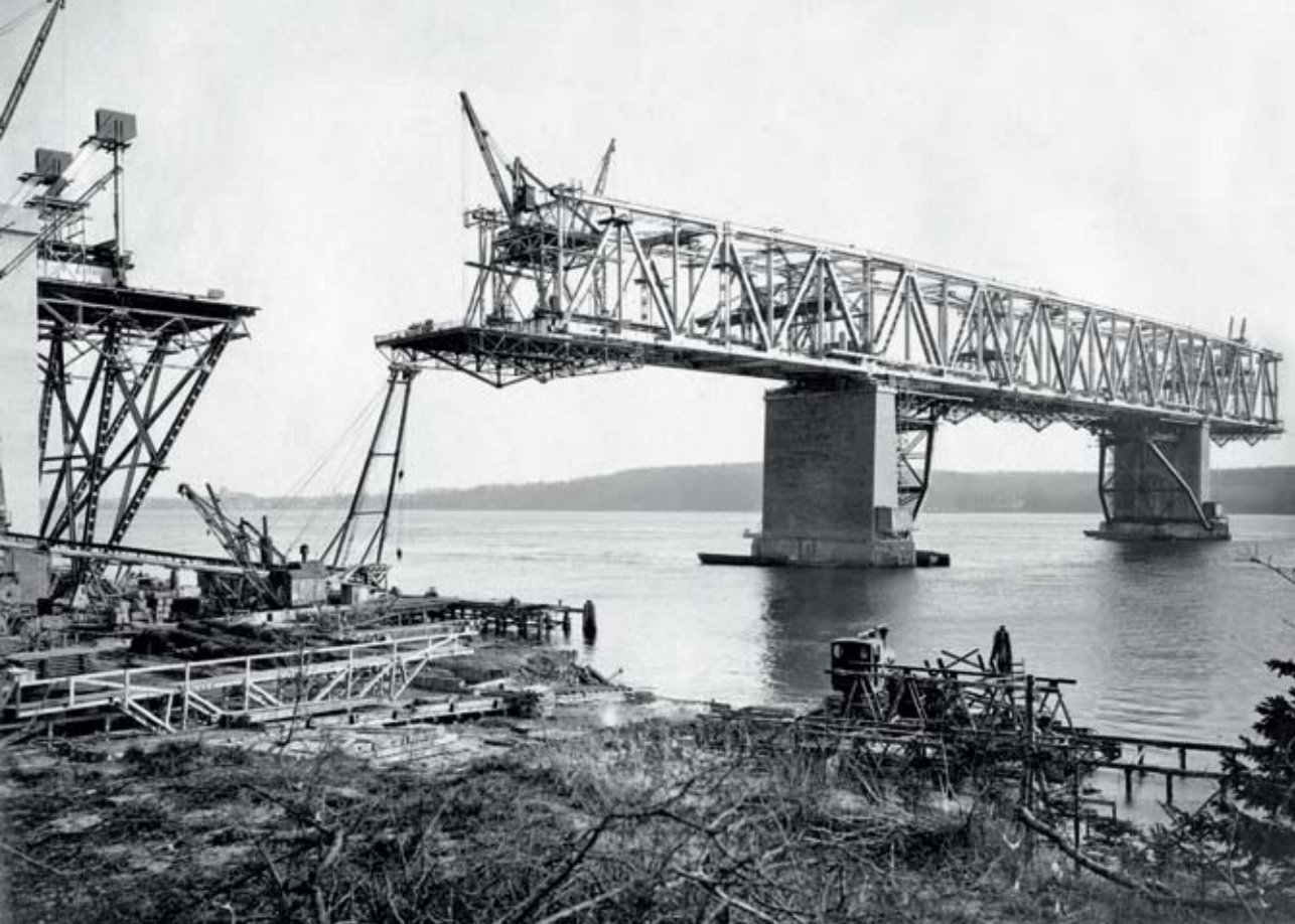
Ståloverbygning forår 1934 færdiggjort mellem strømpille 4 og 3.
