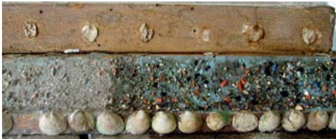
Detalje fra sokkel, højre side rengjort.
