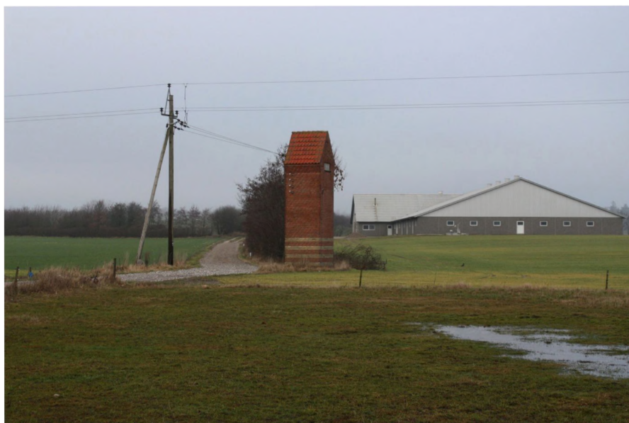
Figur 106: Transformortårn nord for Gelstrup, eget foto 2009.
