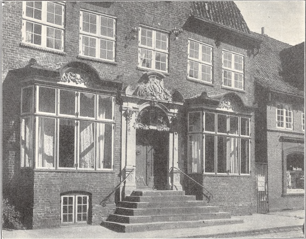
Vestergade 9 i Tønder. opført ca. 1770.
