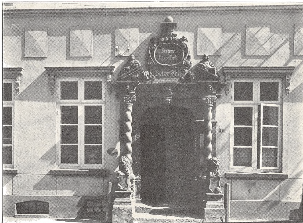
Store Apotheke i Tønder, opført ca. 1650.
