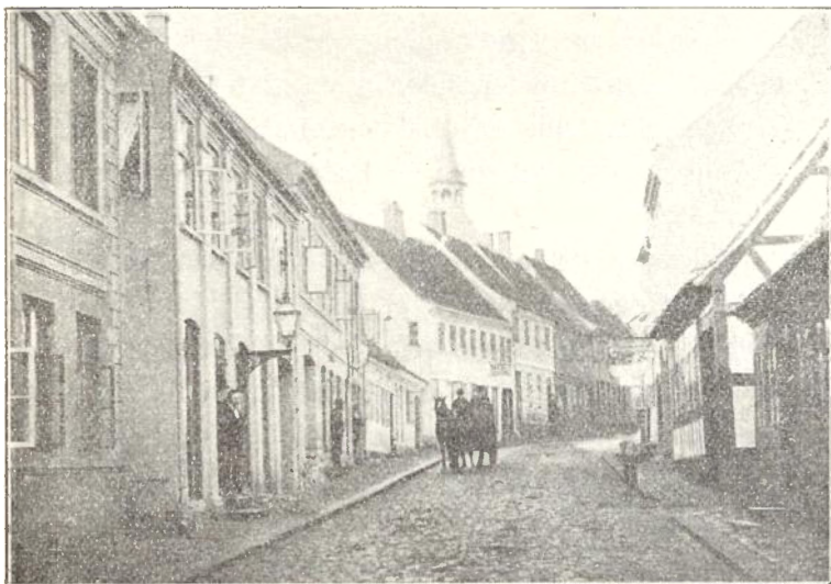
Brogade før Banen kom; efter det første Hus tilhøjre ses Skolestræde.
