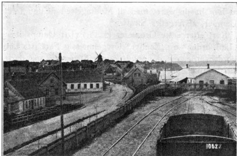
Struer Østergade først i 1870'erne, set fra Banegaardsvej.
