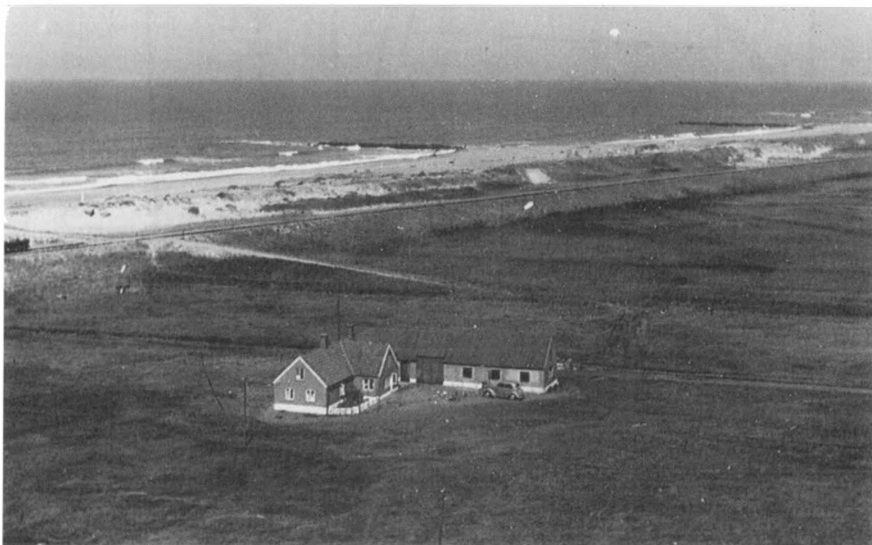
Fig. 15. Jens Tofts ejendom på Sdr. Langer. Luftfoto ca. 1950. Pladsen ber, matr. nr. 38 b, er stedets tredje beliggenhed, siden Jens Tofts morfar, C. N. Bruun, flyttede ud på Mandsbjerg enge (matr. nr. 5) sidst i 1820'erne. Bygningerne blev ryjopført efter brand i 1904 og lå omtrent ud for høfte 44. Høfte 45 og 46 ses i baggrunden. (Edv. Tof, Lemvig).
