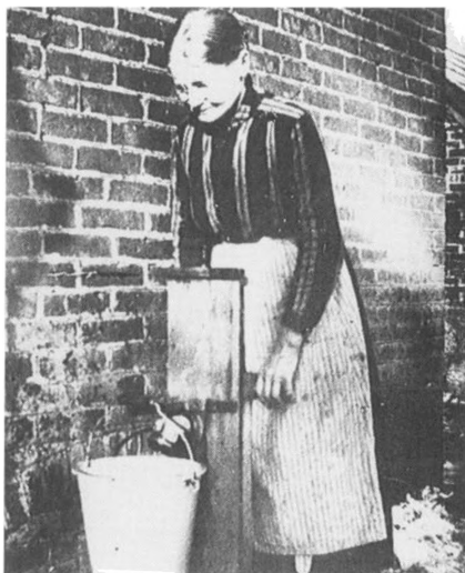
Cecilius Petersens kone, Sidsel, ved vandpumpen ca. 1920.
