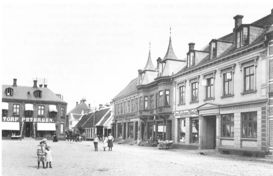
Fig. 9. Intet billede kendes af C. C. Aggersborgs hus i Lemvig fra 1820. En senere bygning på stedet tog sig sådan ud ca. 1905 (huset til højre). Også i 1820 har der været en port gennem forhuset ud mod kirkepladsen (Lemvig Museum).
