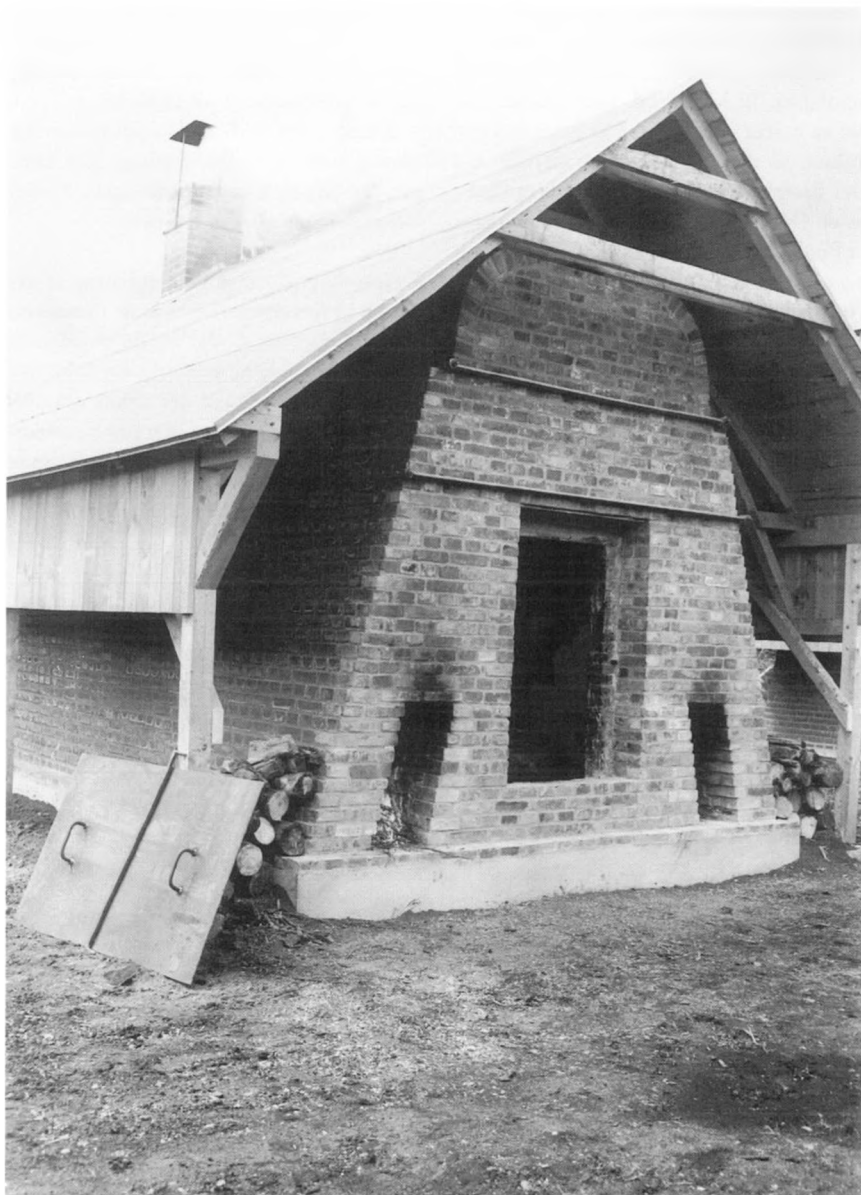
Rekonstrueret tjæreovn i Hesselvig plantage ved Skarrild. I midten den store åbning, hvor træet indføres. Ved siderne ses indfyringsstederne. (Foto: Herning Bladet).
