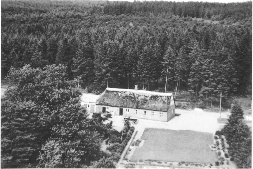
Plantørhuset fra 1885. Efter luftfoto ca. 1950.
