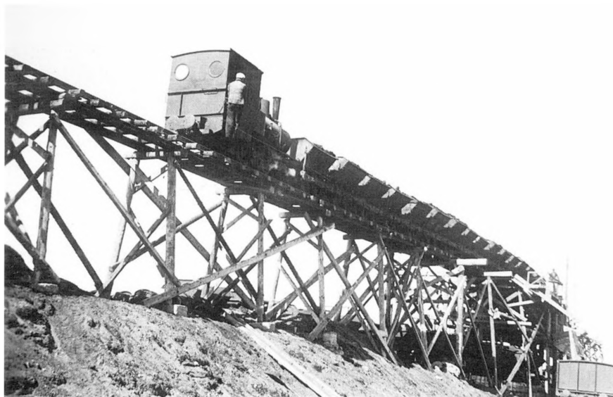
Nr. Vium-lejet. Højbanen, hvorfra kullene over en harpe tippedes ned i jernbanevogne.
