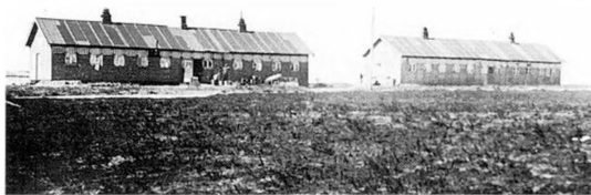
Nr. Vium. I bygningen til venstre var marketenderiet »Hedebloomsten«. I bygningen til højre var beboelse. Der var 2 køjer over hinanden og 4 eller flere køjer pr. rum, så det var småt med privatliv, men billigt. I sovebarakken i Ejstrup-lejet var der 3 køjer over hinanden.
