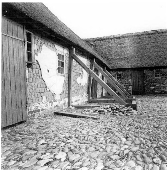
Ladens sydmur var for en stor dels vedkommende opført i ubrændt klegsten. De første restaureringsarbejder var en afstivning af denne mur. Bemærk pikstensbrolægningen.
