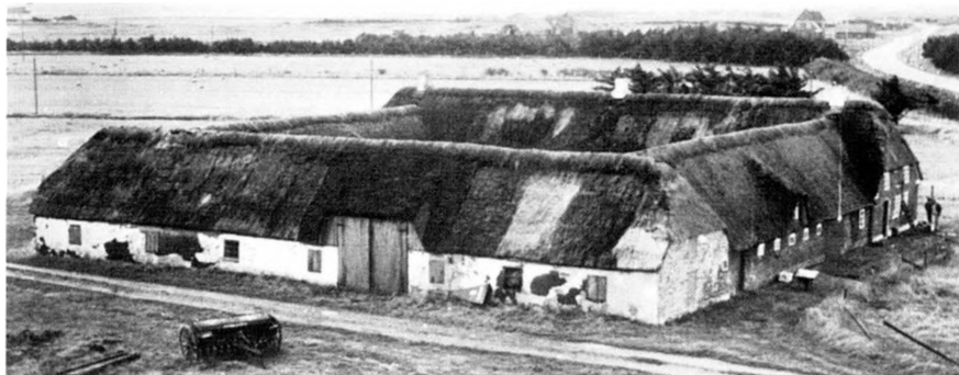
Abelines gård set fra klitten nord for gården, 1970. Både vægge og tagflader trænger til istandsættelse. De ubrændte klægsten i ladens nordvæg har delvist mistet den beskyttende kalkede overflade.
