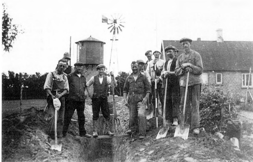
Borris kloakeres i 1939. Vindmøllen pumpede vand op i vandtårnet. Fra venstre: Rørlegger Emanuel Mikkelsen, Niels Hansen (højpuldet hat), ukendt, Svend Rahbek (på brædtet), Nikolaj Lund, af de 4 følgende er de to Henry Jacobsen og Viggo Gosvig, yderst Peder Brølling.
