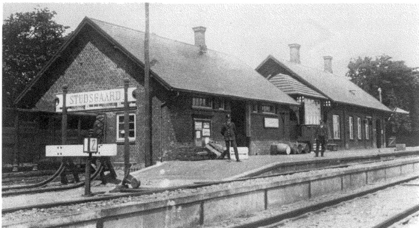
Studsgaard station omkring 1920. I signalhuset, som ses mellem stationsbygningen og pakhuset, var stationens dengang nye sikringsanlæg anbragt. (Lokalhistorisk Arkiv, Herning)
