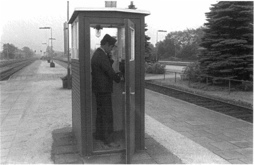
Stationsbestyreren på Skjern station frigiver en togvej i fungekiosken på perronen. Foto fra 1979. (Tage Skøtt)
