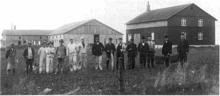
Håndværkere og forsøgsfolk opstillet foran byggeriet i 1909. Far står som nummer to fra højre. Til højre ses den færdige forsøgslade og til venstre avlsbygningerne under opførelse. Længen nærmest er hestestald og lade, længen vinkelret herpå er kostald og karlekamre, og længen der forsvinder bagud i billedet er svinestald. Avlsbygningernes form ses bedre på luftfotoet fra 1935 senere i artiklen.
