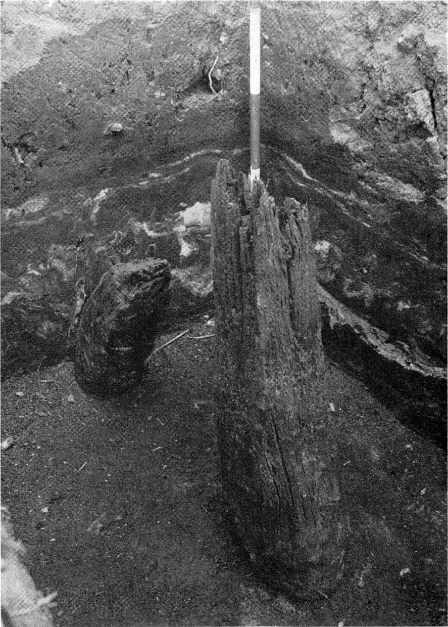
Fig. 5. Tilbage af jernalderbroen står i hvert brofag to stolpesæt, hvert sæt består, som vist her, af en lodretstående stolpe og en skråtstillet støttestolpe.
