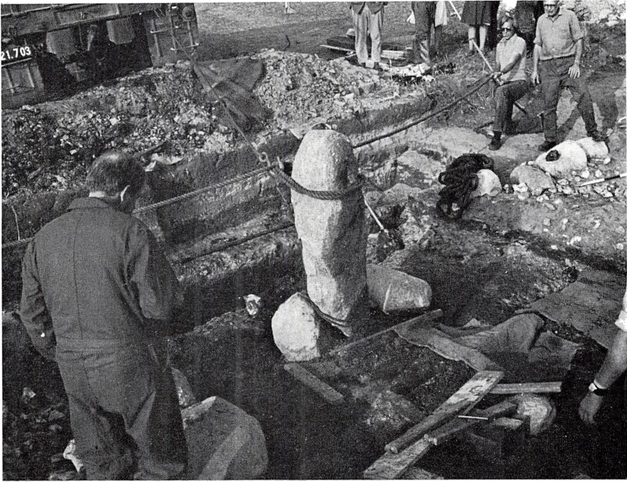
Fig. 11. Den store sten, der understøttede svellevejens midte og hvilede på tvejen, vejede over 700 kg og måtte med største forsigtighed fjernes med kran. Det lykkedes, uden at det gik ud over trægenstandene 17 .
