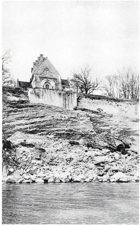
Kirkens østgavl med den nyopførte støttemur.
