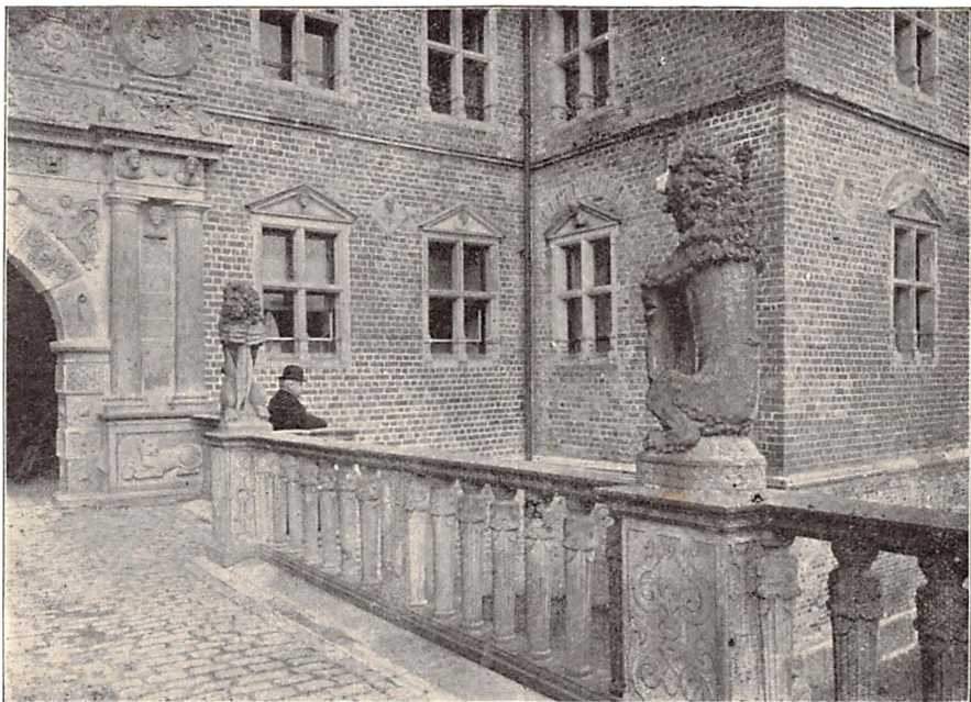
Slotsbroen. Vindebroen fandtes tidligere mellem de 2 Lover.
