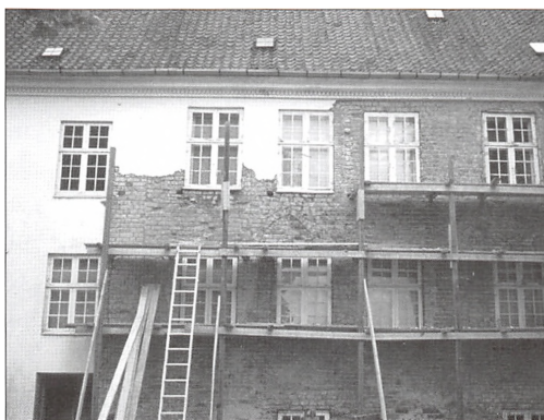
Ved renovering af murværket på Saltøgårds hovedbygning fremkom sporene af de oprindelige middelalderlige døre og vinduer. Foto Erik Olsen begyndelsen af 1970'erne.
