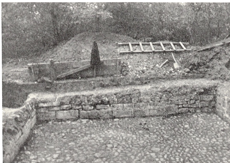
Fig. 6. Vestmuren, set fra østmuren.
