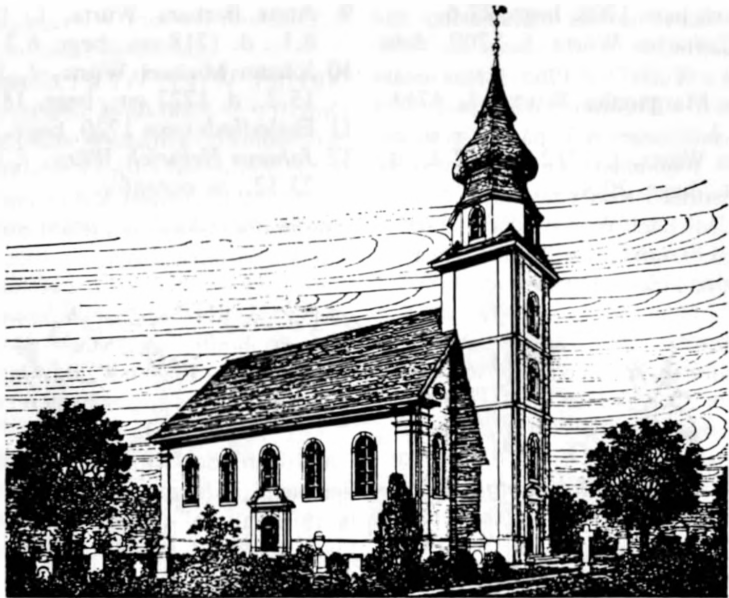
Den reformerte kirke i Schriesheim, opført 1748-51.
