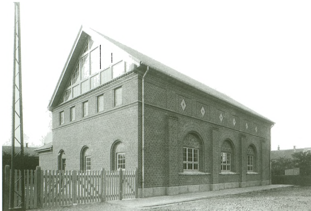
Silkeborg Elektricitetsværk 1911 i Hostrupsgade.
