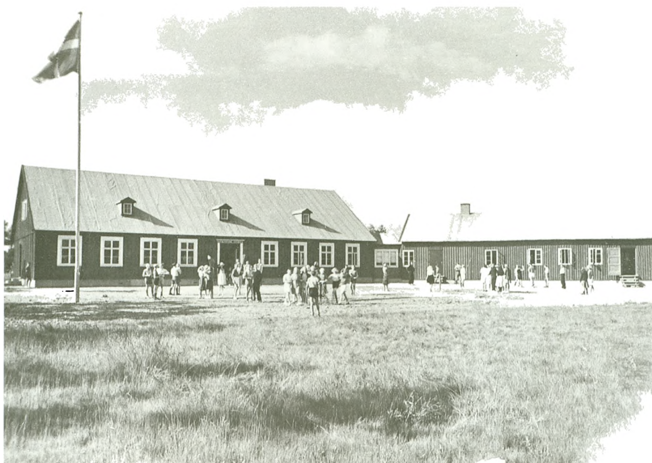
Silkeborglærernes Feriekoloni på Ahl Hage blev taget i brug i 1948. Ved 40-års jubilæet i 1988 skete en renovering af de gamle bygninger, og en ny værelsesfløj blev indviet. Billedet er fra 1949.
