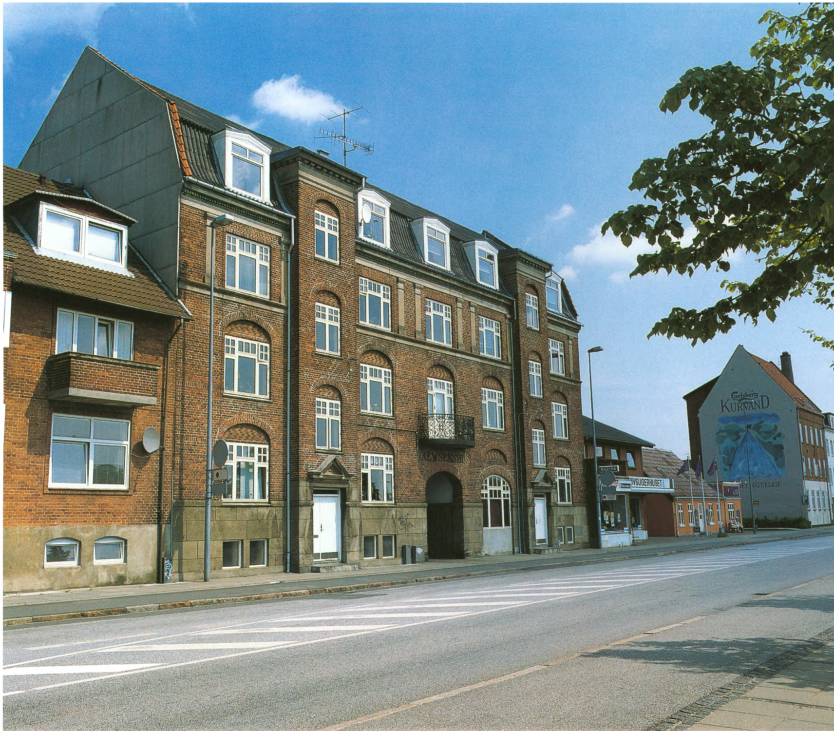
Edv. Jensen: Drewsensvej 62-64 opført 1910-11. Foto 1995.
