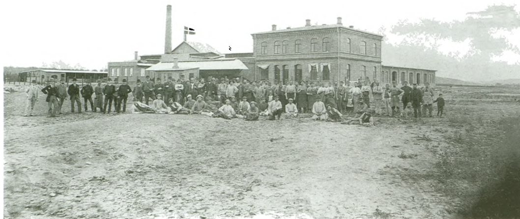
Koopmanns Svineslagteri 1889. Det private slagteri kom først, etablerede sig hurtigt og lovede bønderne højere priser. Derfor måtte ideerne om et lokalt andelslagteri udskydes i små 20 år.
