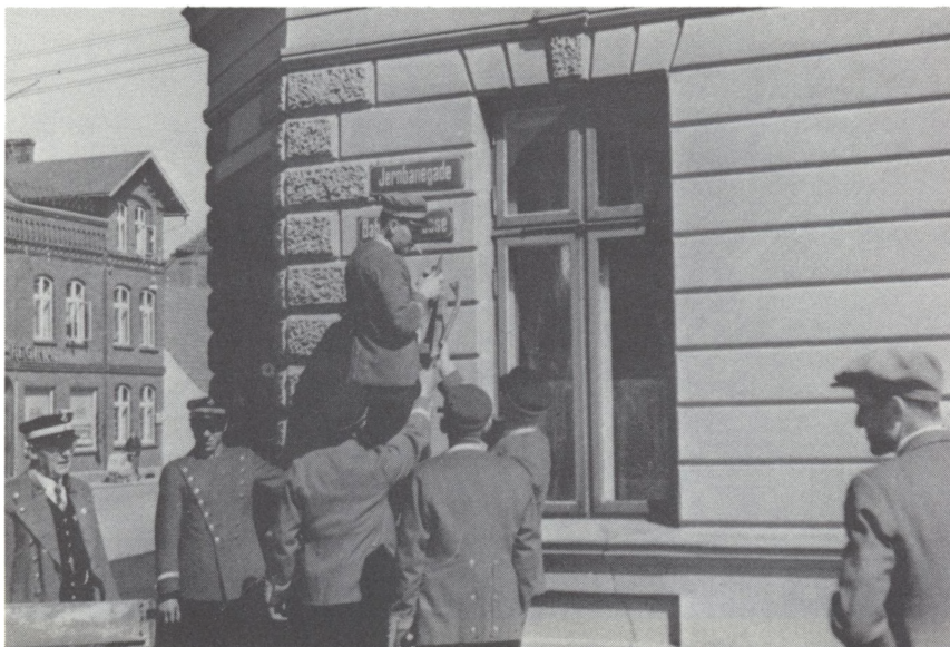
Hjørne med skiltene Jernbanegade og Bahnhofstrasse. På stigen Fr. Lund.
