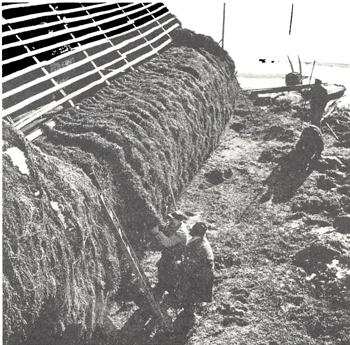
Fig. 15. Tangtagets konstruktion på Læsø. De såkaldte vasker på de nederste lægter danner en bred vold. – Fra genopførelsen af gård fra Læsø på Frilandsmuseet.
