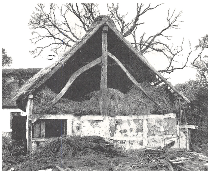
Fig. 7. Fynsk sulekonstruktion af den ældre type med lange bladede skråbånd. – Gård i Graderup, Brenderup sogn, under nedbrydning.
