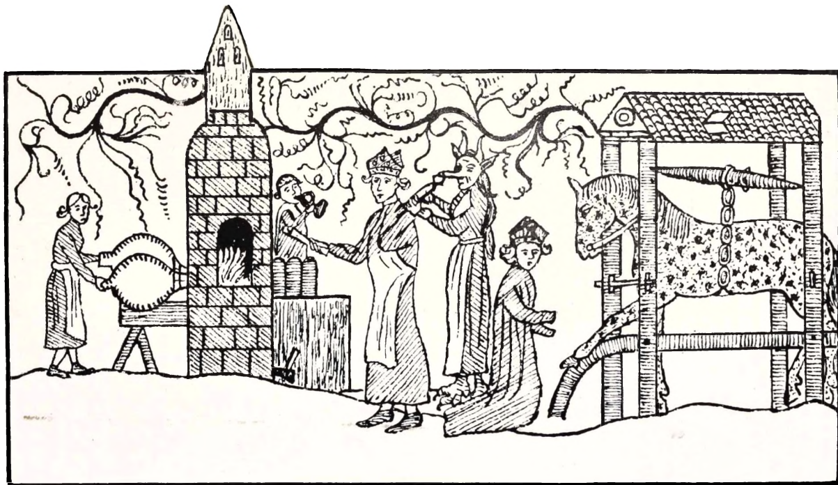
Kalkmaleri paa den nedrevne nordre Mur i Stubbekøbing Kirke
