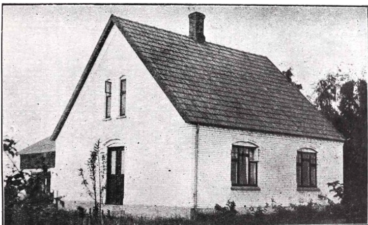
Et af de ny Statshuse ved Egense.
