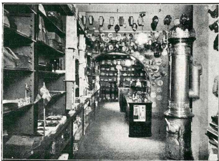
Interiør fra Høier Olsens Køkkenudstørsforretning.
