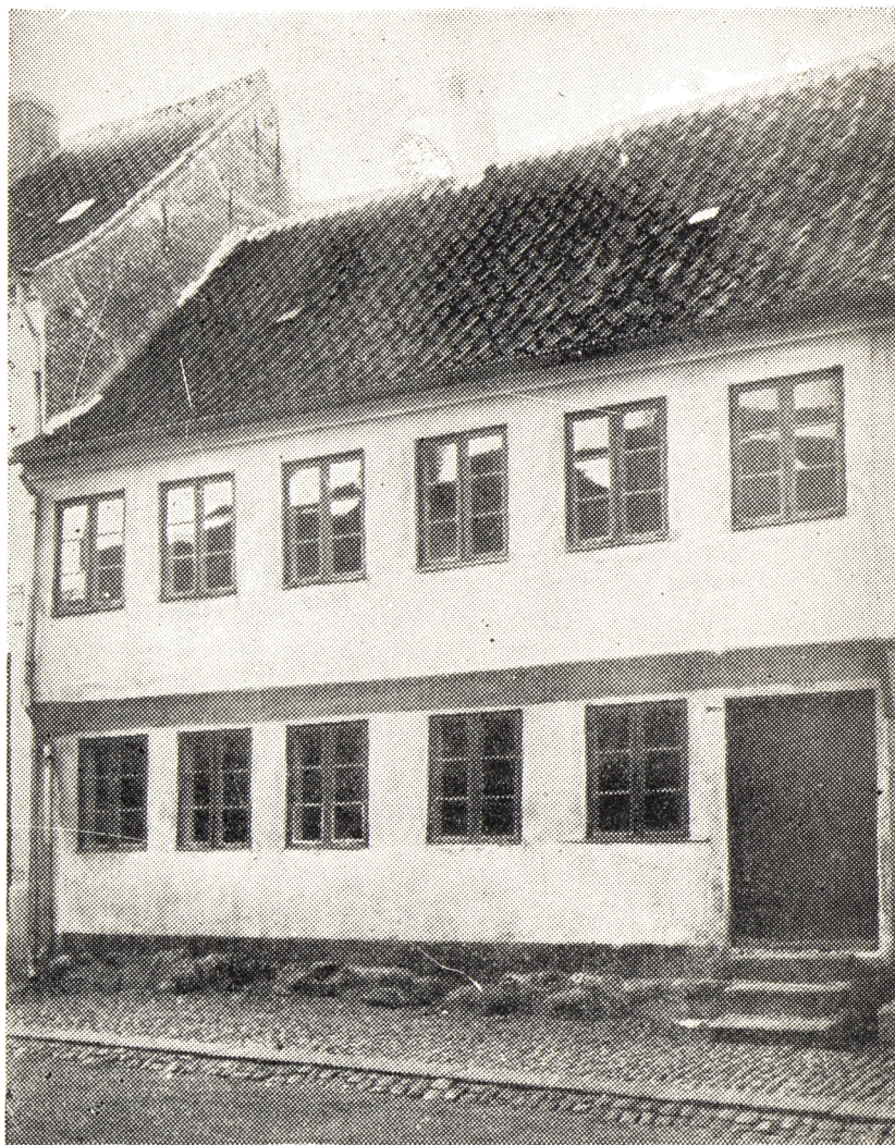
Huset i Algade, nedbrudt i Juni 1929.
