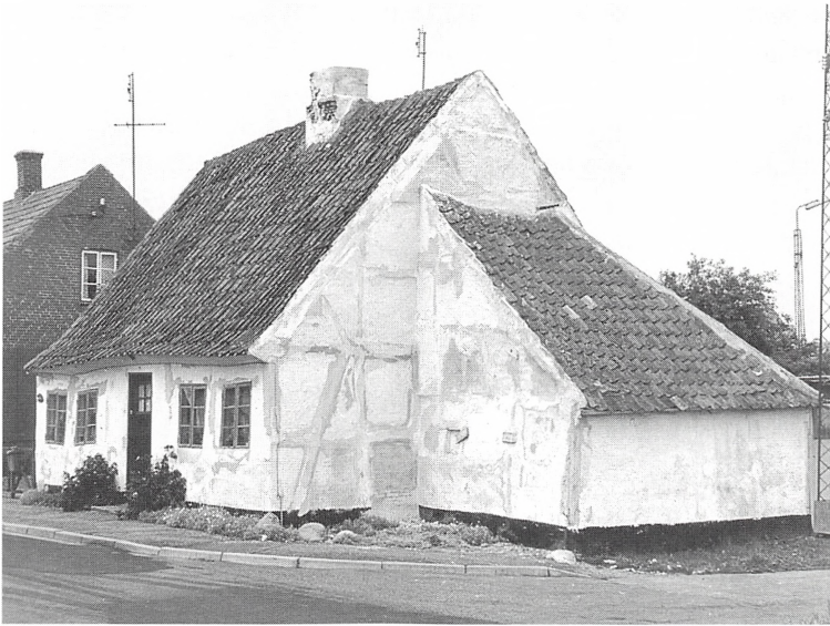
Accisebod fra ca. 1690 i den vestlige udkant af Rødby. Acciseboden blev benyttet som toldbod frem til 1820, da anløbsstedet i Rødby blev nedlagt. Anløbsstedet lå ca. 200 m vest for acciseboden. Foto i Told•Skat Museet.
