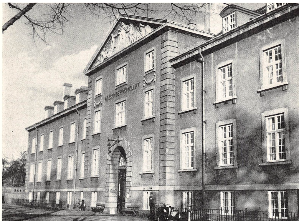
Øresundshospitalets hovedbygning. Fot. 1961
