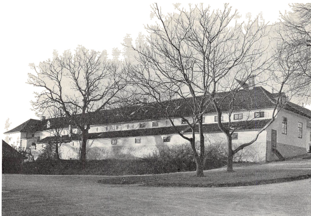
Sct. Hans hospital. Bygningen, der blev bygget 1813–14 («slottet»). I forgrunden den gang, der benyttedes til bortfjernelse af latrin fra sygecellerne. Nu bruges bygningen til administrationskontorer o. lign. Fot. 1961
