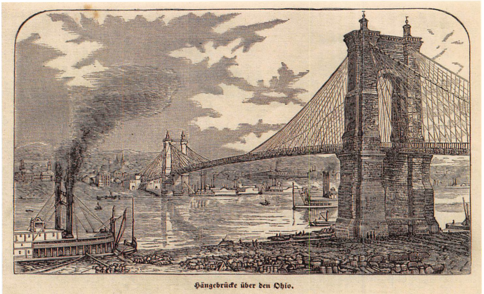
Abb. 16: Röbling-Hängebrücke über den Ohio, 1869, Verbindung nach Covington KY
