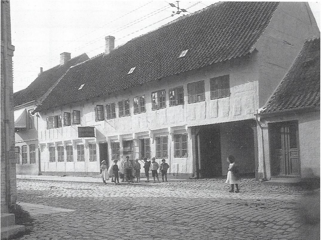
Sådan så Peder Nolds købmandsgård ud, da Hugo Matthiessen kom forbi i 1913. Gården, der kan føres tilbage til omkring 1600, eksisterer stadigvæk. Disharmonien i den øverste vinduesrække afslører, at de fem fag længst til venstre oprindeligt har udgjort en selvstændig ejendom. Peder Nold lagde de to grunde sammen i 1752. Fotografi i Nationalmuseet.
