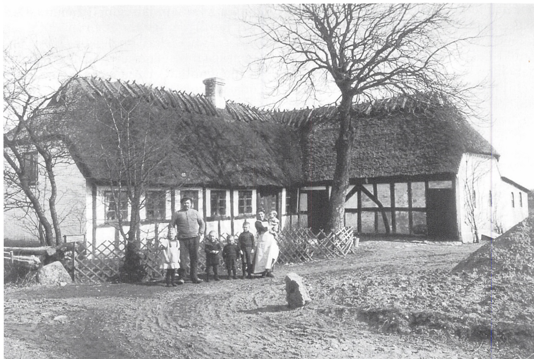
Matr.nr. 52d på Hovbanken i Rønninge fotograferet omkring 1915. Huset havde da samme størrelse som da det i 1849 blev brandforsikret for første gang, men det var siden blevet forsynet med brændte sten i stedet for lerklinede vægge. Huset var indtil 1867 fæstehus under Rønninge Søgaard, hvorefter det overgik til selveje. Enken efter den tidligere fæster blev boende i huset, og køberen forpligtede sig til at give hende aftægt, mod til gengæld at betale lavere renter af Rønninge Søgaards prioritet så længe enken levede. Foto: Langeskov Kommunes Lokalhistoriske Arkiv.
