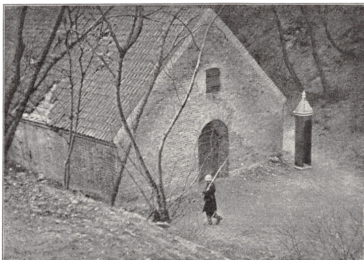
1. Krudttaarnet i Dronningens Bastion. Fot.
