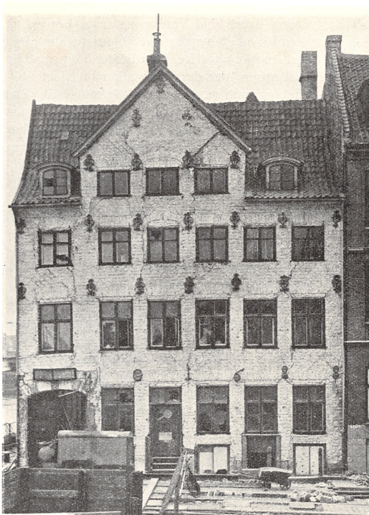
Brogade 3, efter at Façadens Puds var afhugget. Fot. Hannuss.
