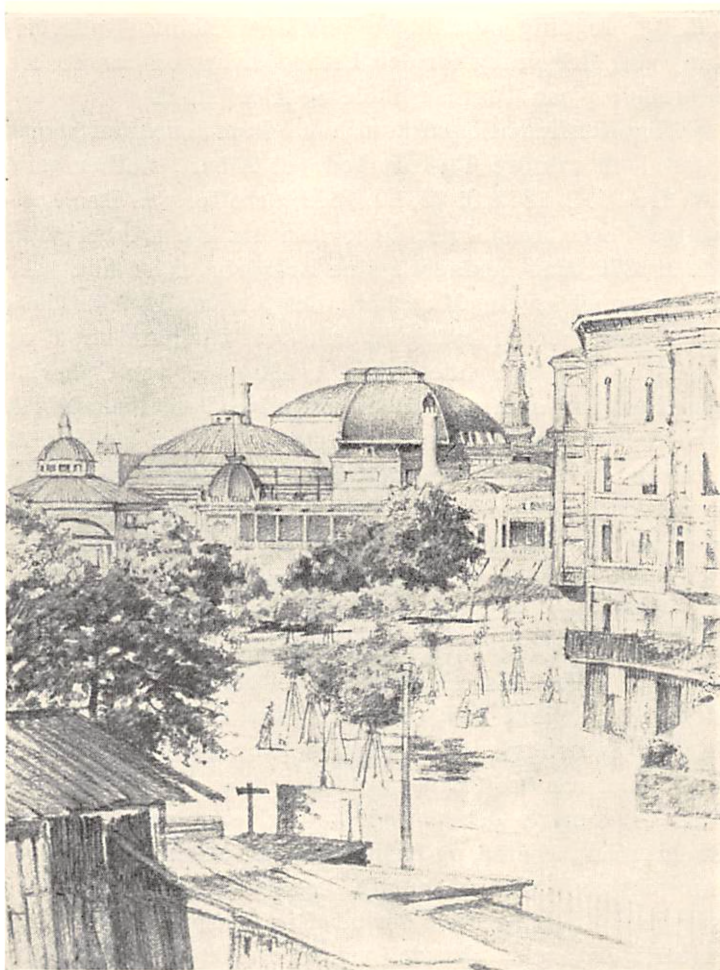
Udsigt fra Malerens Vindue i Reventlowsgade 6 over Tømmerpladsen mod National (nu National-Scala) og Cirkus. I Forgrunden Hjørnerne af Bernstorffsgade. I Baggrunden foruden Cirkuskuplen Dagmarteatrets Kuppel og Petri Spir.
