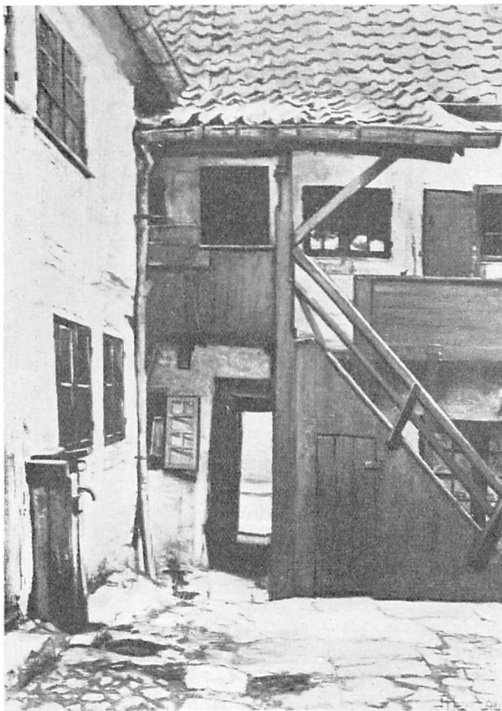
Gaardparti: Toetagers Bygninger. En Fritrappel fører op til en bræddedækket Svale, delvis dækket af et Udhængstag. Under Trappeafsatsen Kig gennem en smal Gadegang. Ved Sidehuset en bræddeklædt Vandpost. Maleri 1907.
