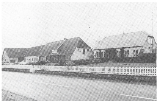
Stolbrogade 14-16 i Stolbro er et godt eksempel på en enlænget alsisk gård oprindelig med påbygget vinkel (en fløj imod vejen, yderst til venstre, er nedrevet); aftægtshus øst for gården. Både gård og aftægt er opført omkr. 1860. Fot. 1990.
