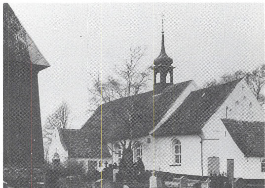
Svenstrup kirke er uden tårn. Her ses den fra sydøst med sin tagrytter fra 1934. Til venstre det middelalderlige klokkehus, der blev restaureret i 1964. Midt i billedet skimtes foran birketræet mindstenen over sognets faldne i Første Verdenskrig. Fot. Nationalmuseet 1959.
