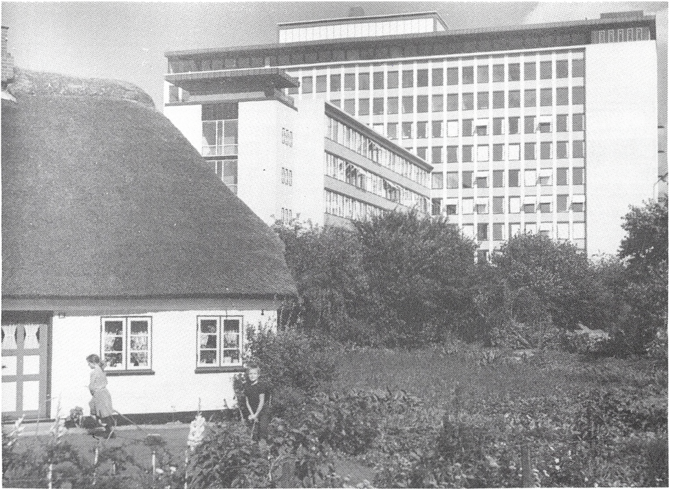
På Nordals kan man opleve kontrasten mellem landbrugssamfundet og industrisamfundet. Danfoss' administrationsbygning i 1960'erne. Fot. Barm van Leeuwen, Nordborg.
