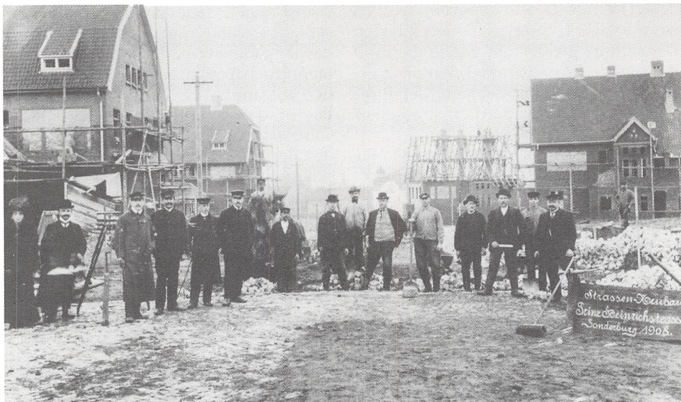
I det nye kvarter omkring den preussiske marinekaserner i Sønderborg, der opstod i årene efter 1900, fik alle gaderne stærkt tyskprægede navne. Det gælder bl. a. Prinz Heinrichstrasse, der fik navn efter den tyske kejsers bror. Gaden ses her under anlæg i 1906. De store admirals- og officersvillaer ligger i dag i Engeshøjgade over for det store sygehus. Fot. Museet på Sønderborg Slot.
