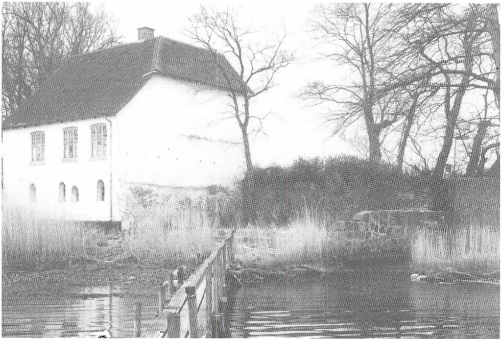
»Møllehuset« og i dets forlængelse brandtomten med ruinresterne af den nedbrændte vandmølle samt udløbet fra den opstemmede sø bag mølledæmningen. Fot. G. Solvang, 1992.
