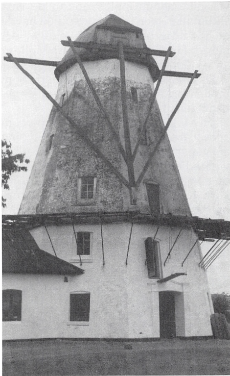
Møllen som den så ud før restaureringen (1982). Alt udvendigt træværk, incl. dele af hatten måtte udskiftes. Foto: Sillerup Mølle
