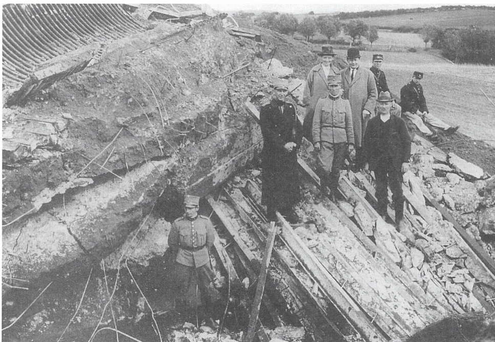
En vellykket sprængning af bunker ved Vedbøl bragte de forjættede og værdifulde jernbaneskinne frem i dagens lys. Hvem mon var den lykkelige ejer af denne bunker.
