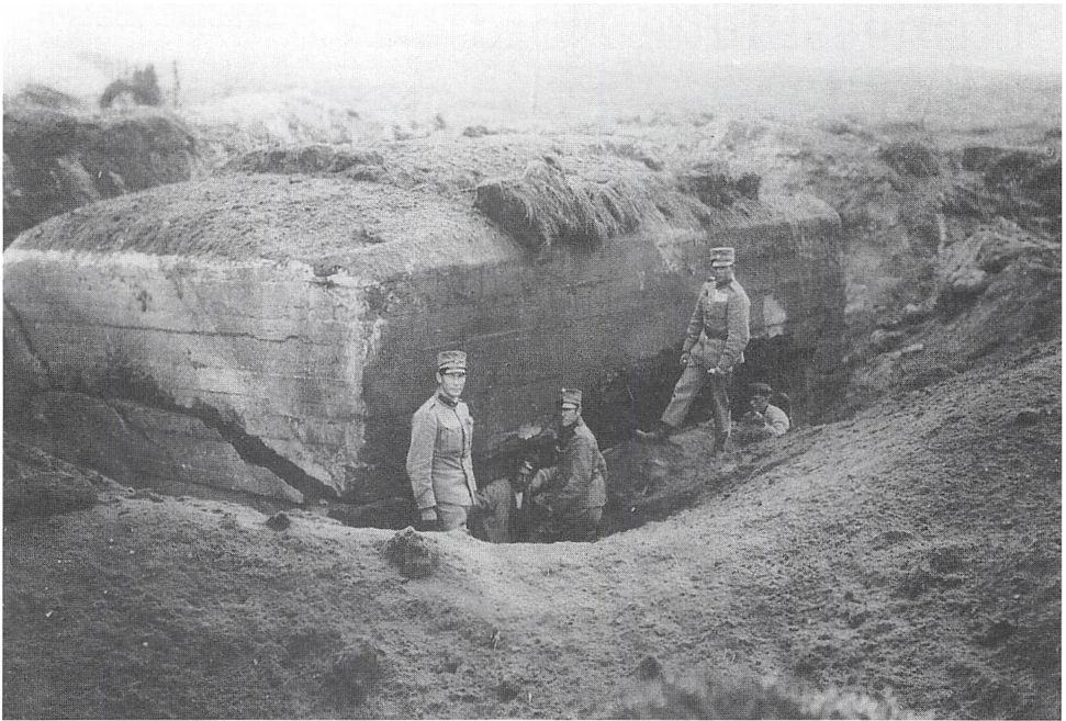
»På den igen« har meldingen til disse pionerer nok været. Toppen er sprængt løs, men har lagt sig til hvile på sin gamle plads.
