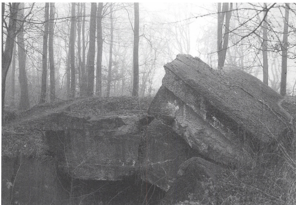
Ruiner af det sprængte Gammelskov-batteri. Metertykke jernarmerede betonnure er kastet rundt. Foto: Jesper Tofft.
