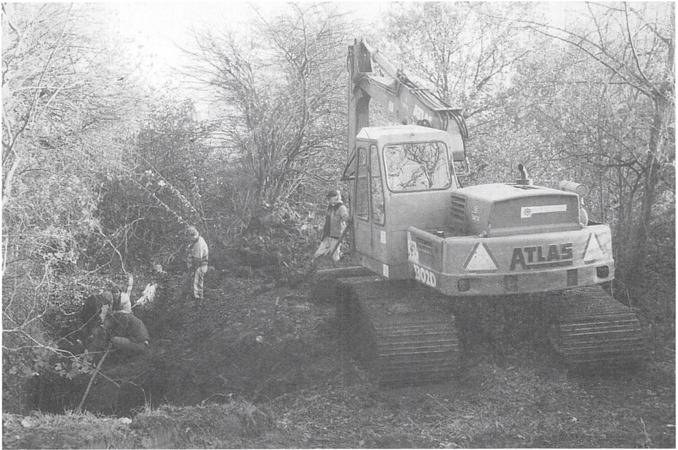
Et arbejdsbold i gang med rydning og udgravning af observationsbunker ved Hoptrup. Til venstre er man i færd med at oppumpe regn- og drænvand fra bunkeren. Foto: Jesper Tofft.
