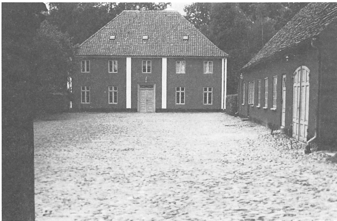
Parti af prins Æmil Augusts gårdanlæg ved Augustenborg, formentlig opført omkring 1765. Set fra øst.
