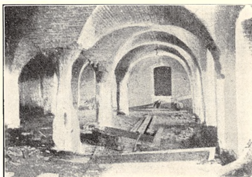
Fig. 6. Granitsøjle næsten sprængt i Stykker.
