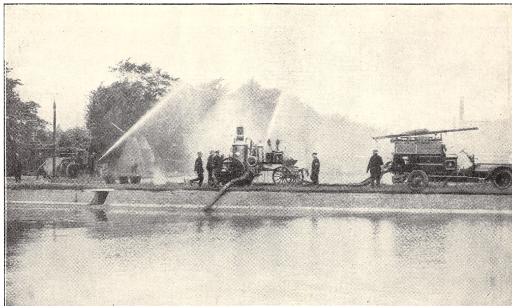
Fig. 14 a. En af Københavns Brandvæsens Dampsprøjter og Dennis Motorsprøjten til Pumpeprøve paa Vandværkets Filterplads i Sommeren 1915.
