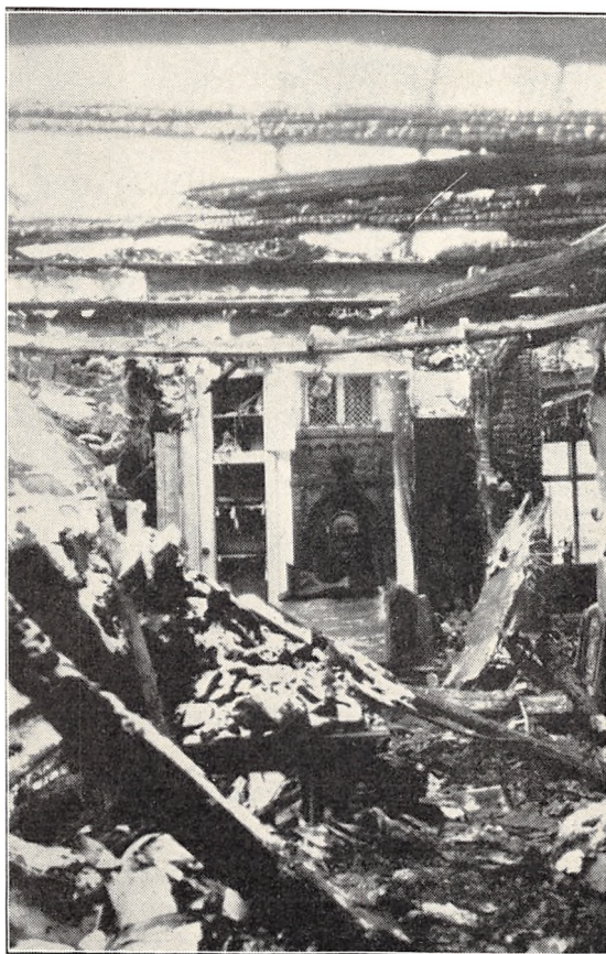
Fig. 4. Jernbjælker bøjes ved Brand, Træbjælker ikke.
