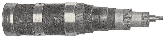
Fig. 7. Blykabel. Fjernkabelanlæg Kolding—Aabenraa—Sønderborg.
