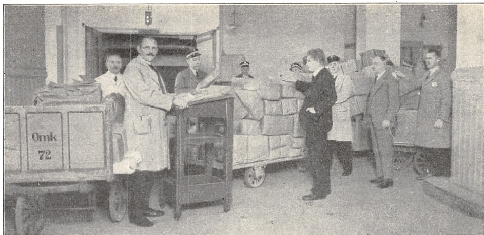
I Elevatorrummet i Kælderen.
