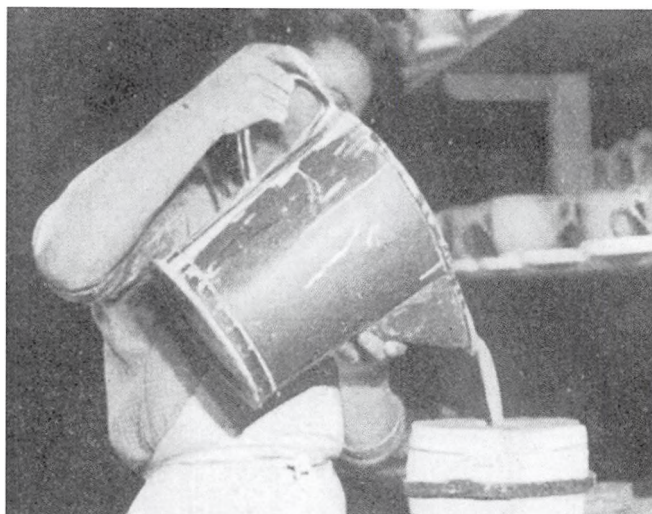
Fig. 2. Støbning af Sukkerskaal i Gipsform.
