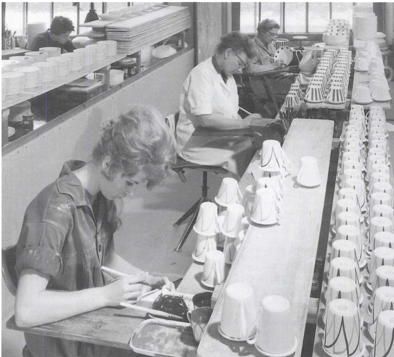
Underglasurstuen med de tre underglasurdekorationer til Dan-ild. I forgrunden er porcelænsmaler Lissie Sørensen ved at male den lyseblå linie på Dan-ild blå flamme kopperne. Kopperne var allerede blevet stemplet i bunden af en dame, der ikke havde anden opgave end at stemple det rå porcelæn. 1962-1964.
