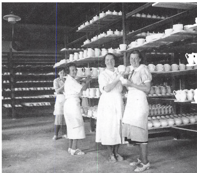
Damerne i porcelænsstøberiet har støbt kander og sukkerskåle, sat hænke på og glattet overfladen. De færdige produkter blev sat på lange brædder og båret på skulderen hen til reolerne, hvor de stod til tørre, indtil de skulle brændes første gang. Støberien, der står som nr. to fra venstre, er ved at skubbe et bræt med Rosenborg mælkekander på plads. Foto Jørgen Balsløv, 1938-1943. Byhistorisk Samling
