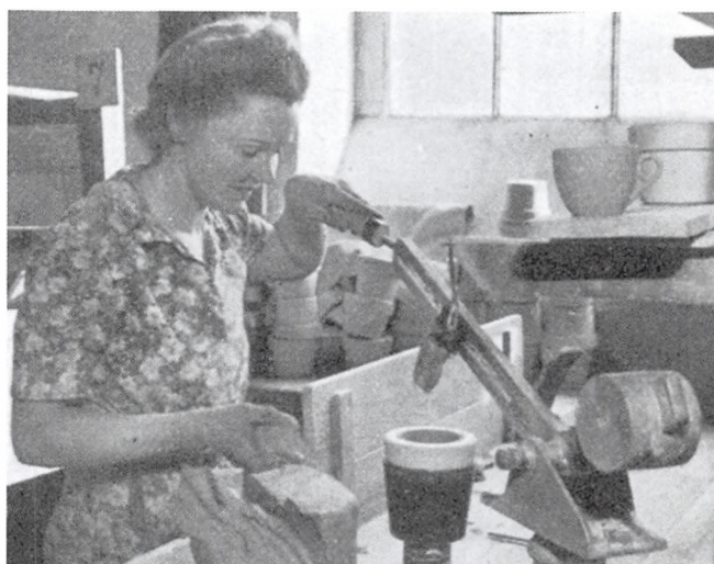
Fig. 3. Kopdrejning i Gipsform.
