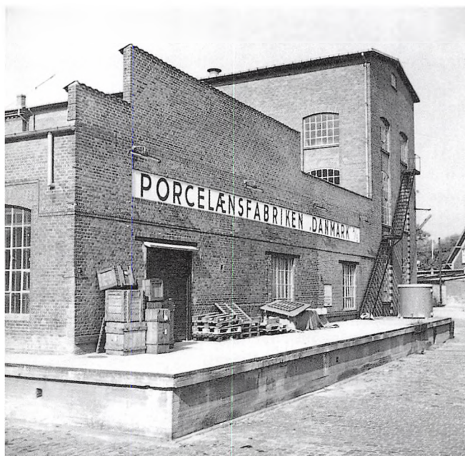
Perronen med port til lagerhallen. Det færdige porcelæn blev pakket i store trækasser til transporten ud til de handlende. Foto Henrik Dupont 1969. Byhistorisk Samling
