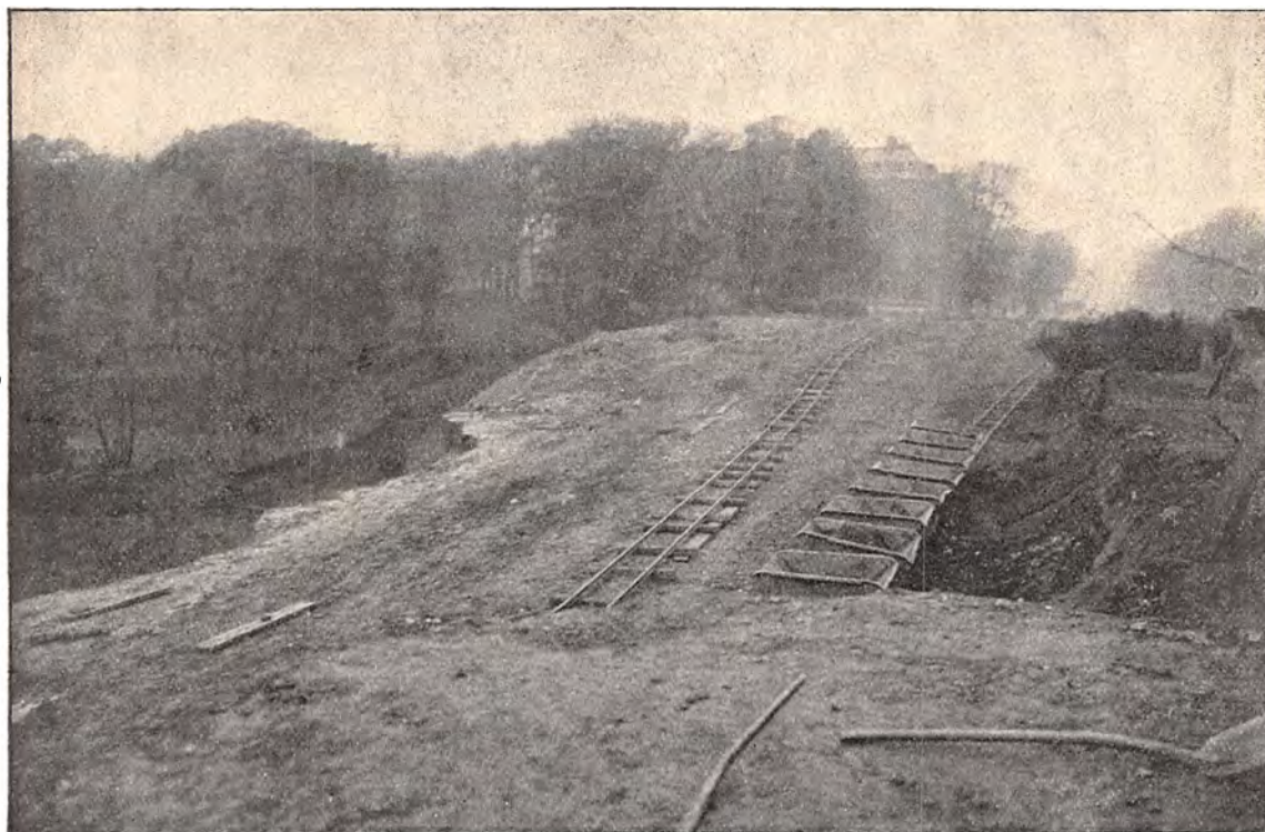
Arbejder i Østre Anlæg ved Udvidelsen af Østbanegaarden. Jul. Aagaard fot.
