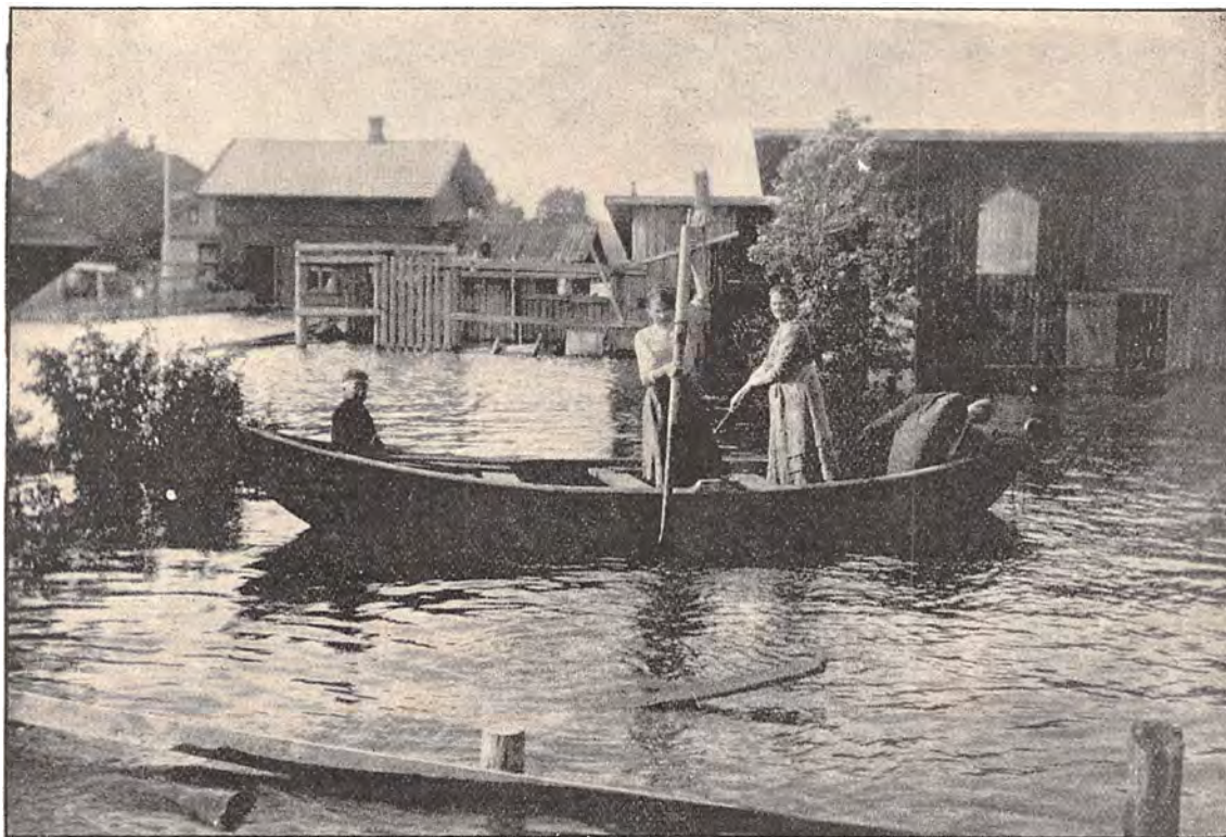
Fra Lillestrøm: En oversvømmet Bydel.
