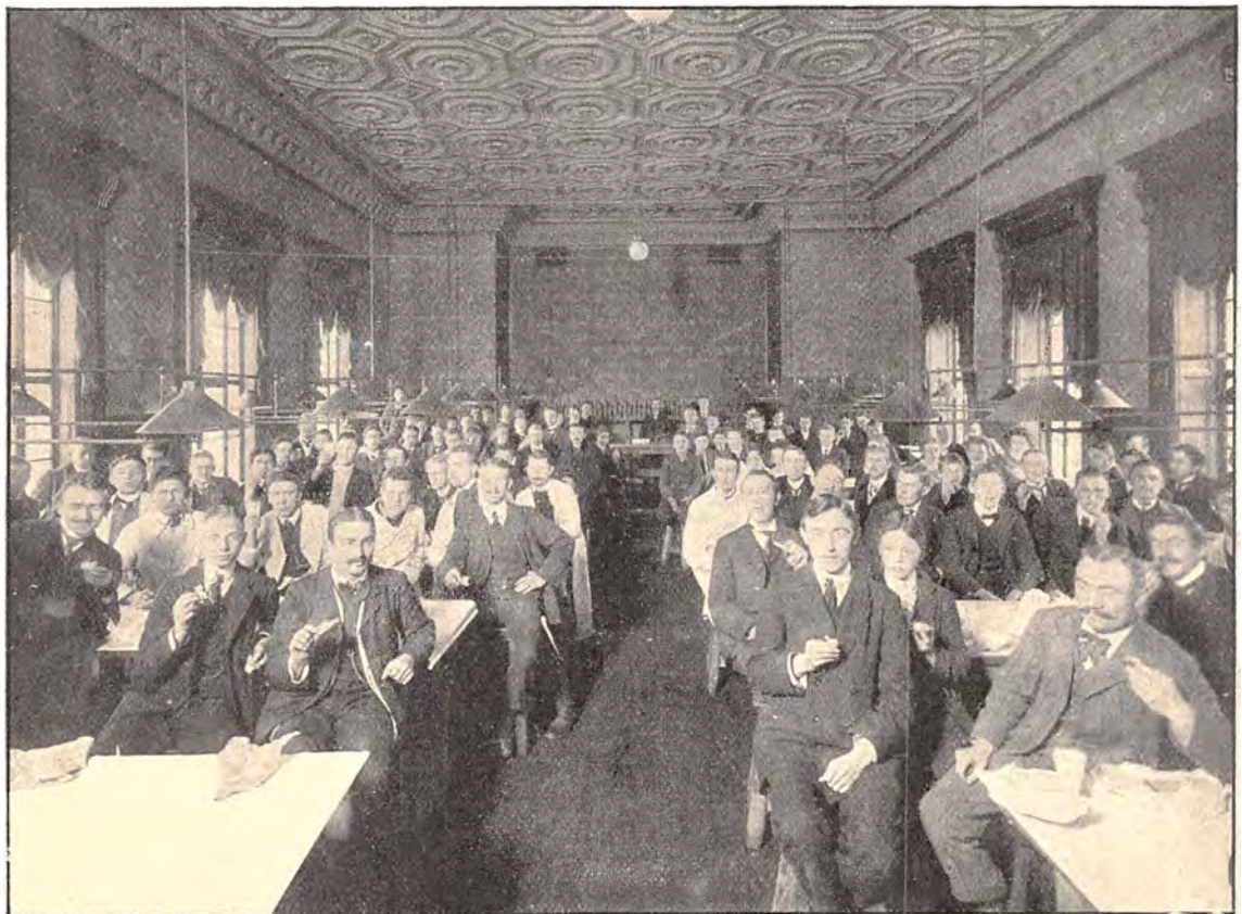
Teknisk Skole. Frokostpavse. Jul. Aagaard fot.
