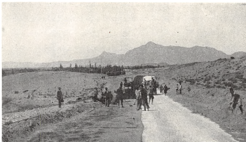
Vejbygning i Iran under Krigen, udført af Kampsax
