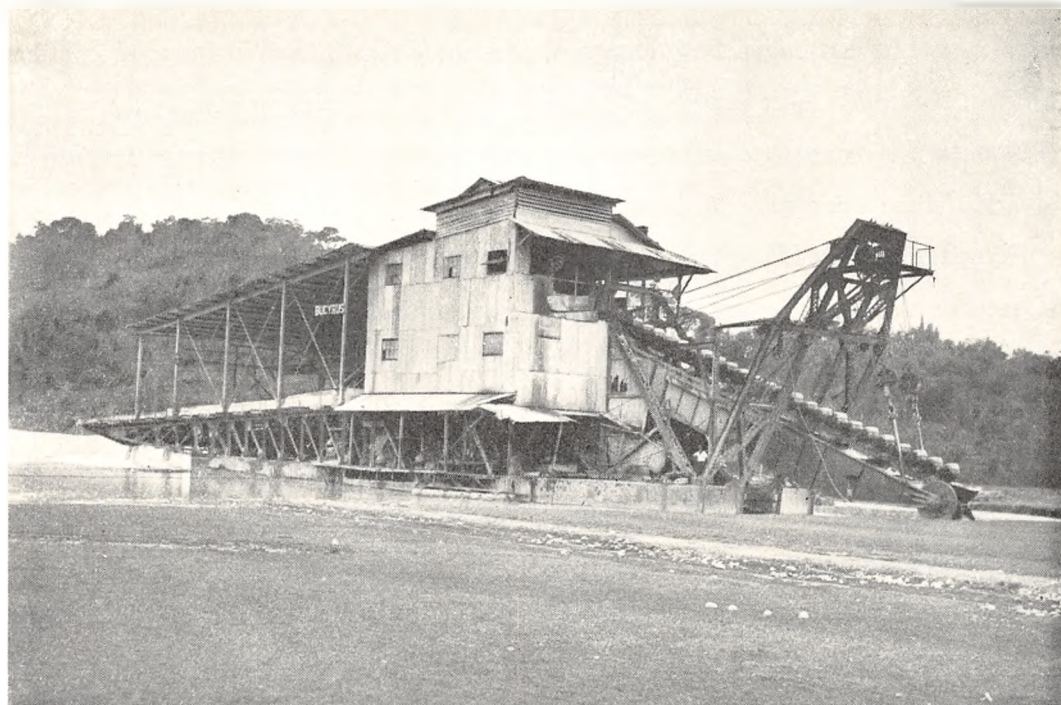
Gravemaskine i Pong Tin Mine, Siam
