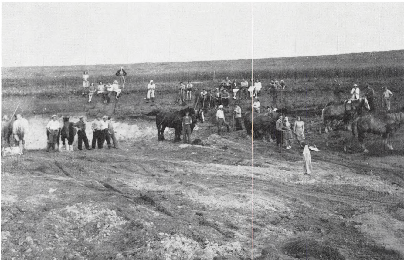
Jordarbejdet ved anlæggelsen af Bjergby sportsplads blev udført af frivillig arbejdskraft.
