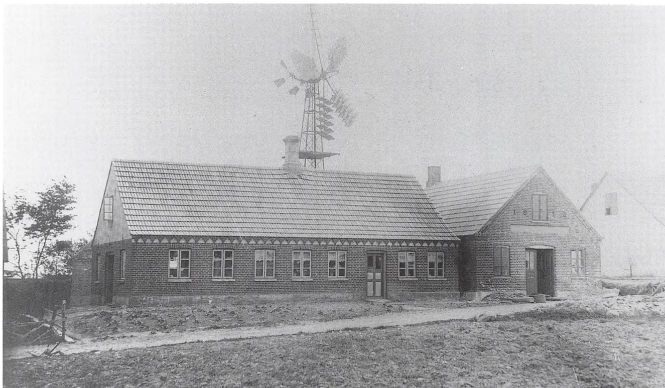
Værkstedet, med gavlen til gaden, blev bygget 1913. Før den tid var værkstedet bag de to vinduer i venstre side af huset. Vindmotoren leverede kraft til værkstedets maskiner.
