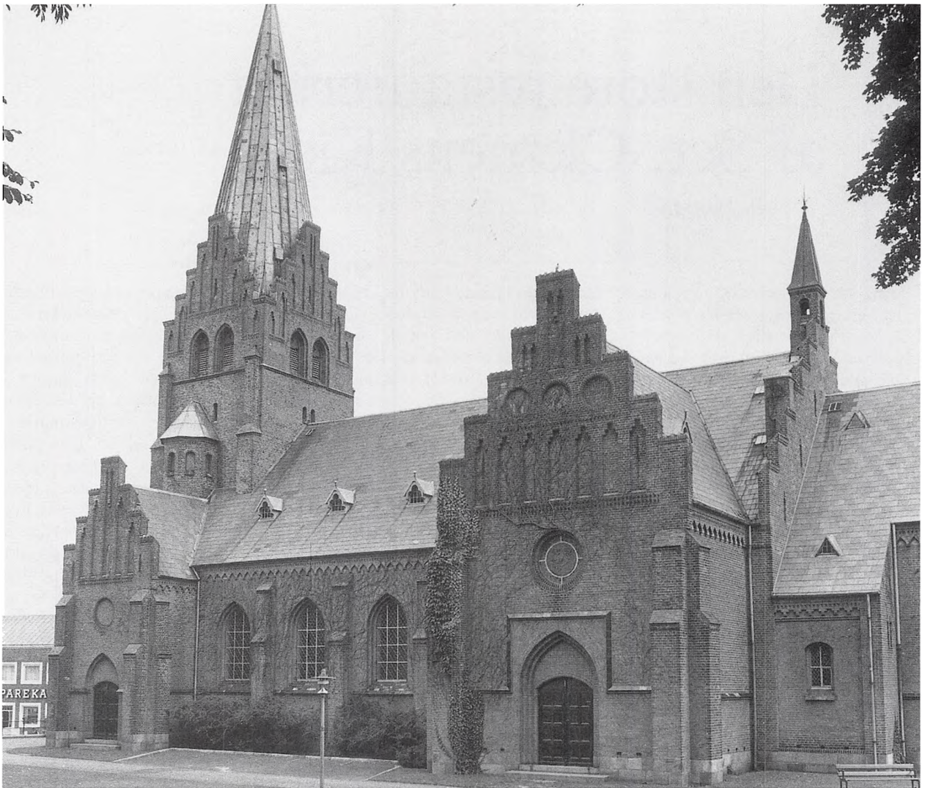
Kirken set fra Toftegade. Billedet er taget efter den store reparation 1976-1982.
