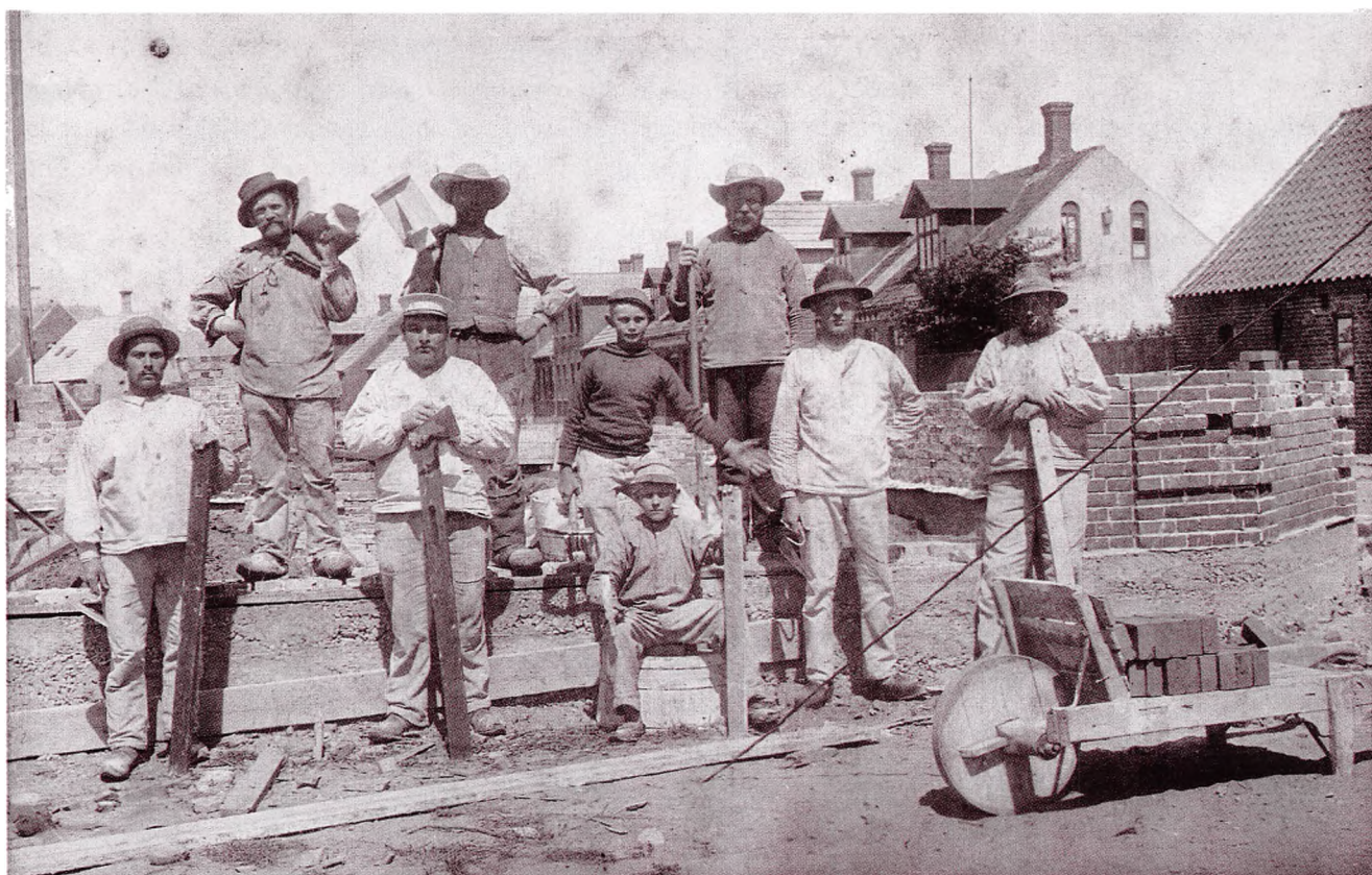
Nybyggeri på hjørnet af Aagade og Grønnegade rundt 1900. Husene i baggrunden ligger langs Aagade. Murenes navne er desværre ukendte.
