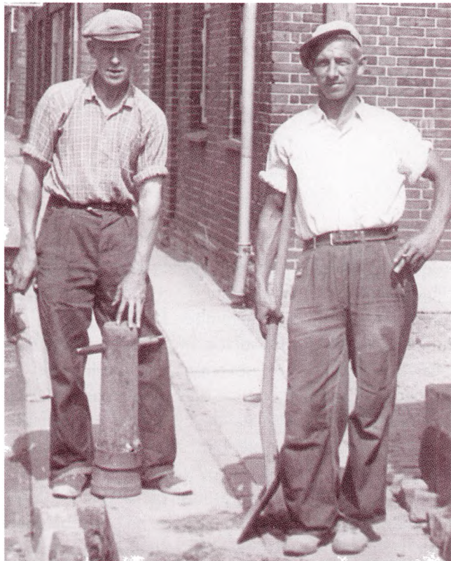
Svend Aage Justesen og Henry Østerballe udfører brolæggerarbejde for Nykøbing Kommune.
