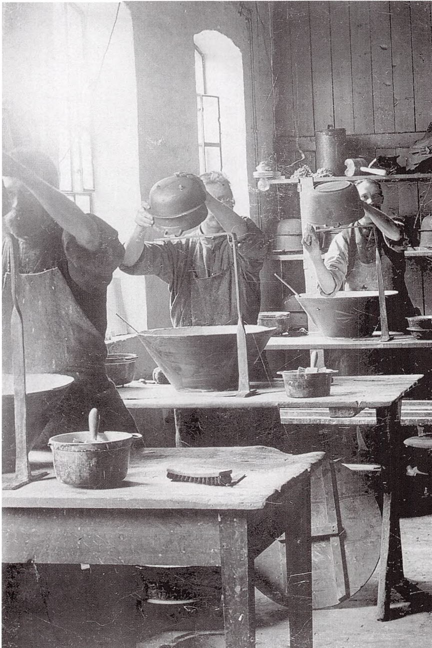
Grydeoptrækkeriet på N. A. Christensens Jernstøberi. Den hvide glasur lægges på indvendig. Senere bliver den hærdet ved brænding.
